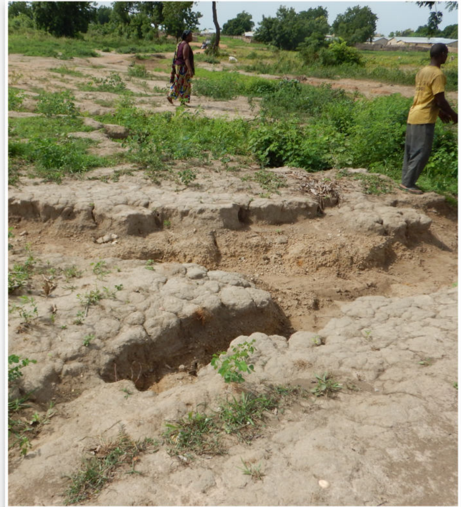
Photo 1 : Erosion à grande échelle
